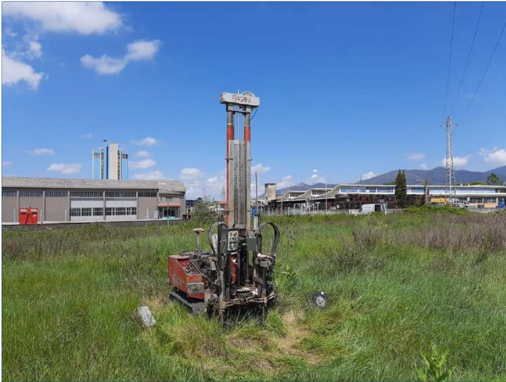
Figura 1: Prova penetrometrica CPT 1
