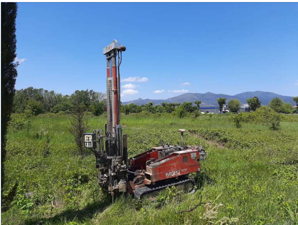
Figura 2: Prova penetrometrica CPT 2
