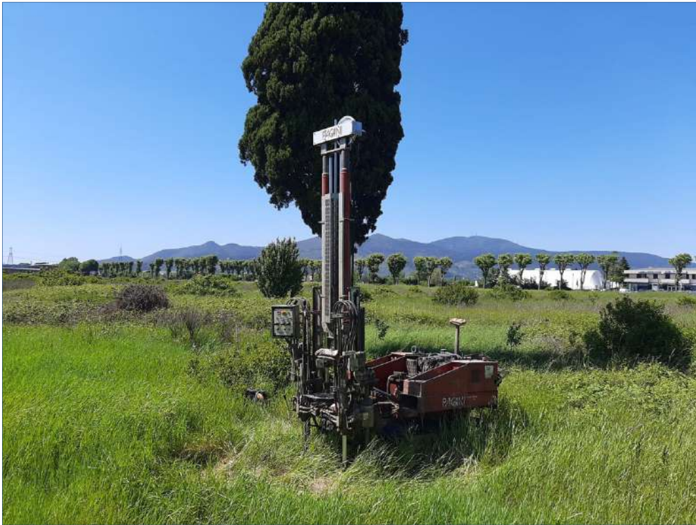
Figura 3: Prova penetrometrica CPT 3
