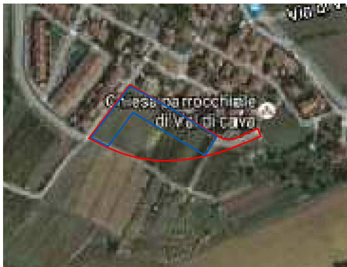
Fig.6 Foto aerea con localizzata l'area a sud oggetto di variante al RU: : in rosso il vecchio comparto del PA, in azzurro i confini del nuovo comparto
