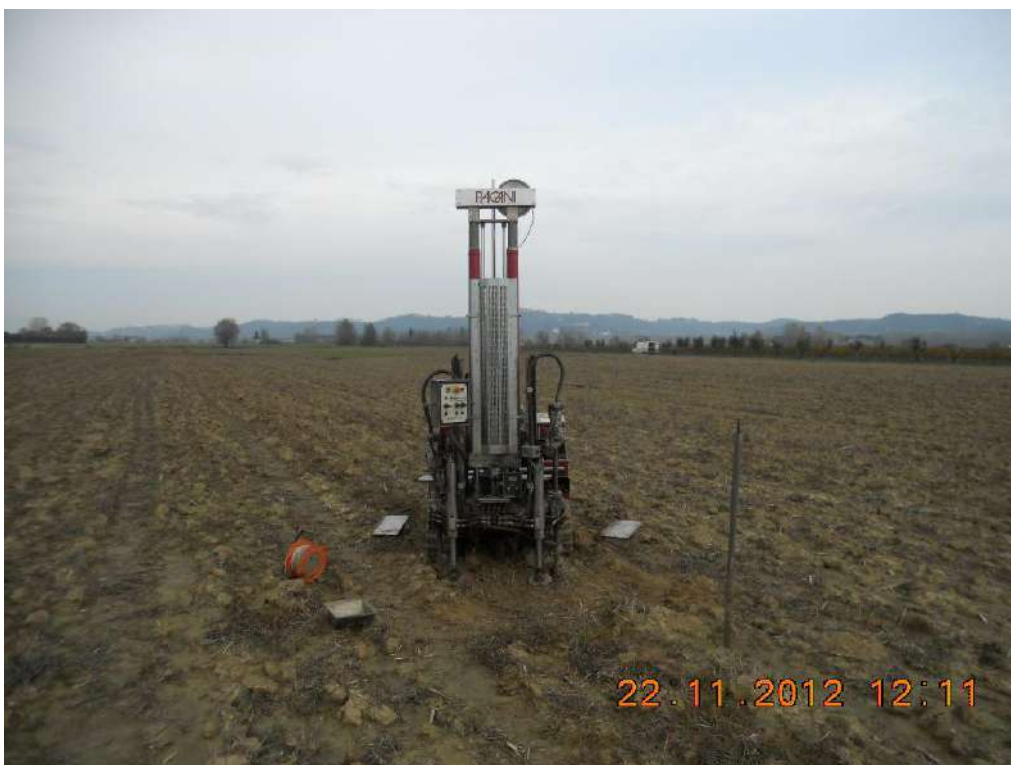
Figura 2: Prova penetrometrica CPT2
