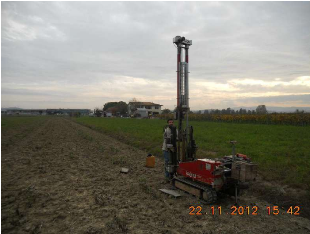
Figura 3: Prova penetrometrica CPT3
