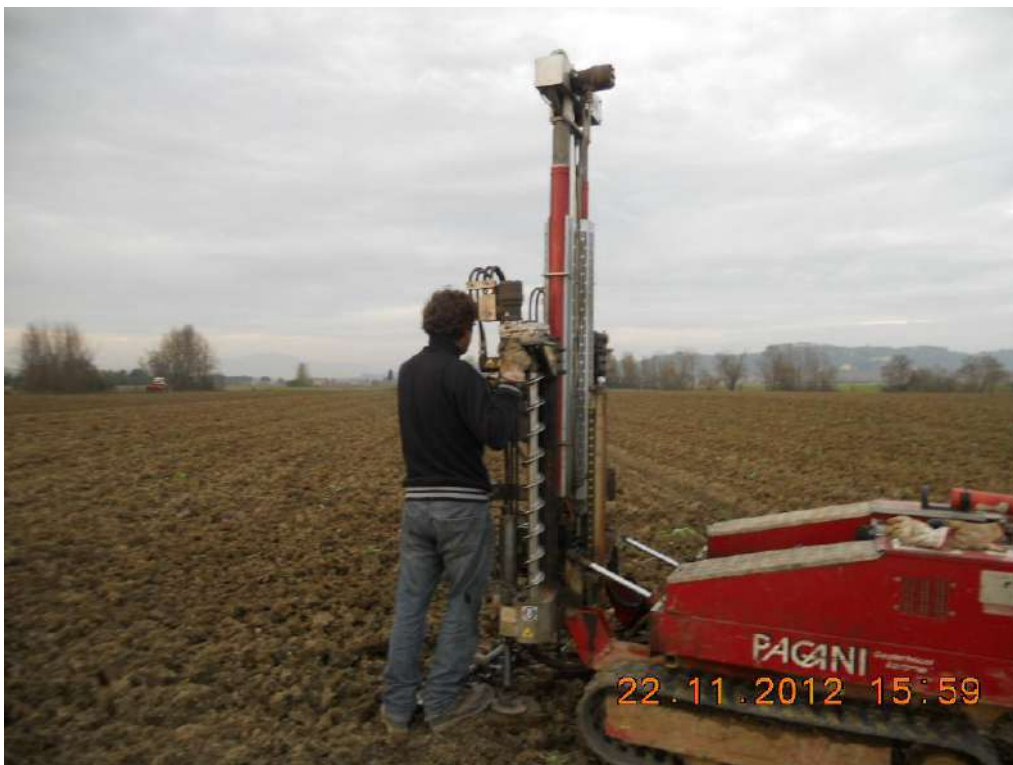
Figura 4: Prova penetrometrica CPT4
