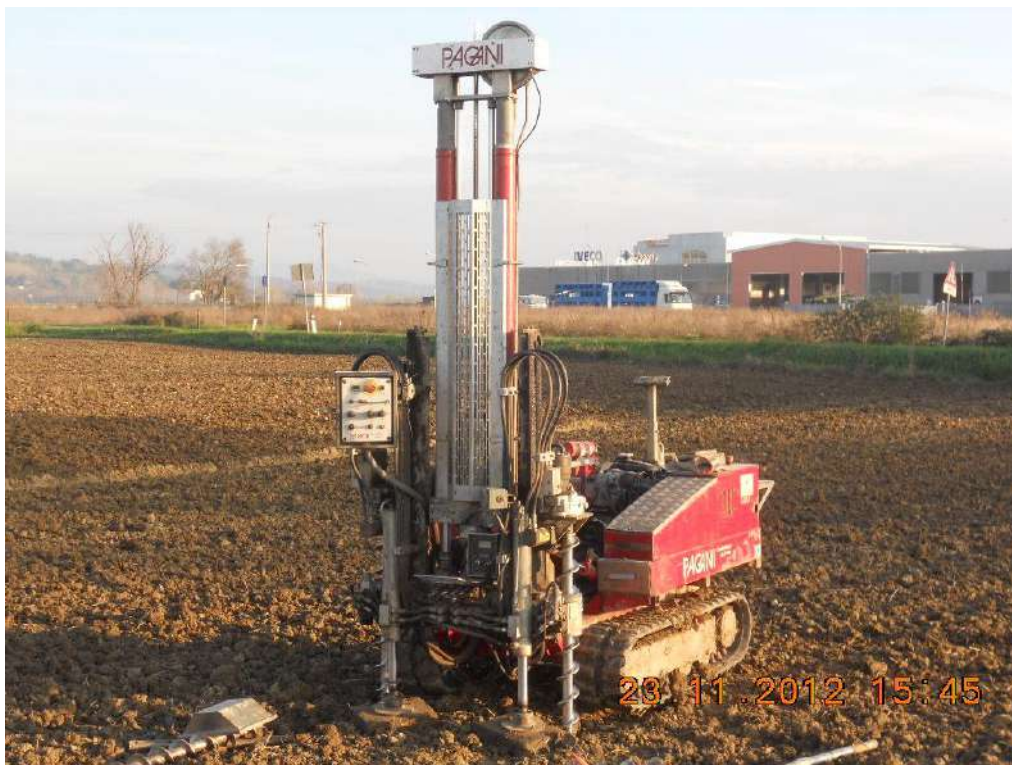
Figura 6: Prova penetrometrica CPT6
